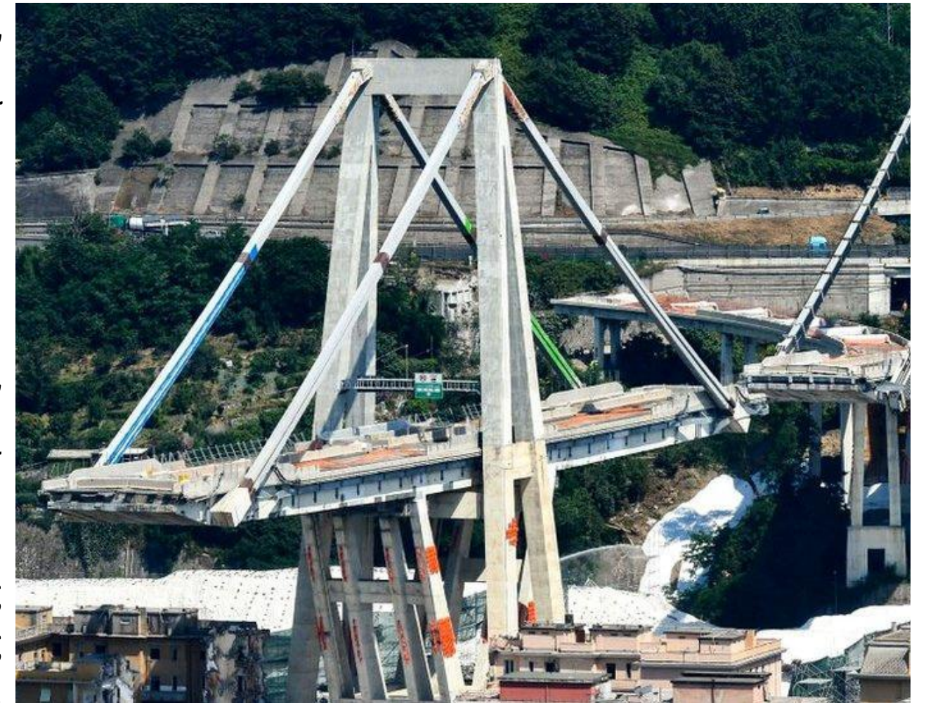
Σχήμα 7: Η γέφυρα Morandi στη Γένοβα της Ιταλίας κατέρρευσε τον Αύγουστο του 2018 λόγω έντονων βροχοπτώσεων.
